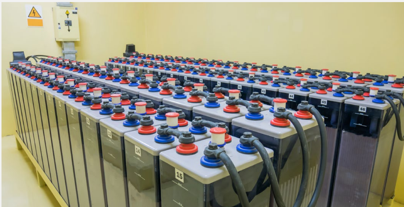
Рисунок 1: Пример стационарного аккумуляторного хранилища
